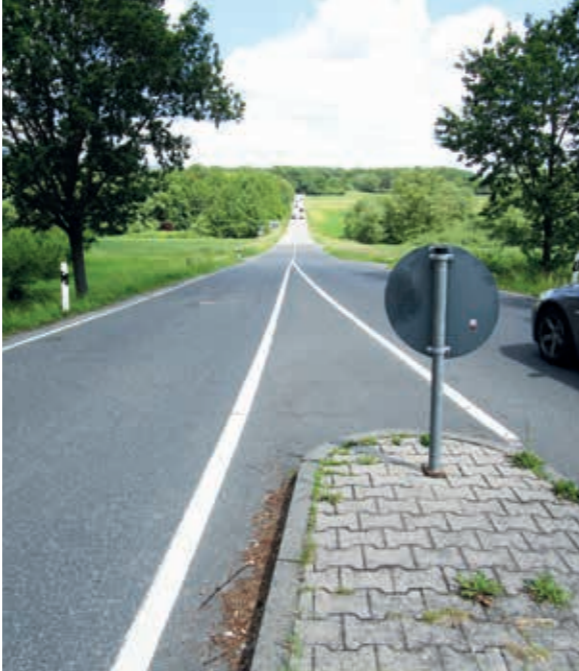
Typische Landesstraße in Hessen: Weder ein Radweg, noch eine Baustelle für einen Radweg in Sicht.
